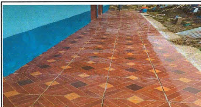
Foto 4: Cambio de piso a piso cerámico corredor
