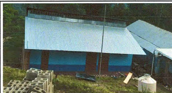
Foto1: Cambio de cubierta modulo I
