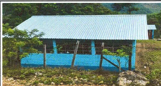
Foto 2: Cambio de cubierta modulo II
