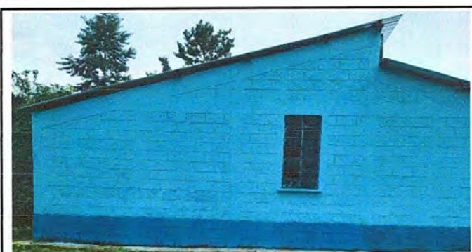
Foto 5: Cambio de pintura
